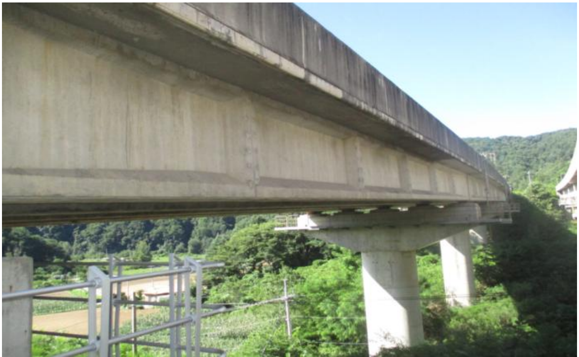
교량 측면 전경
