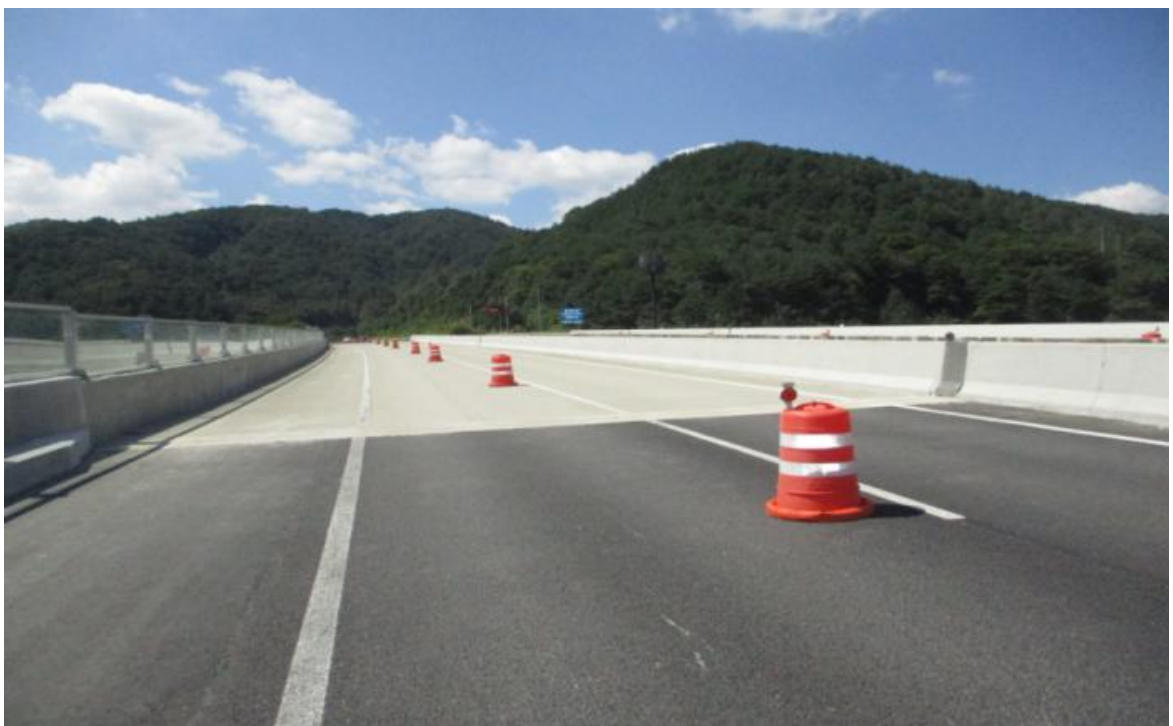
교량 상부 전경
